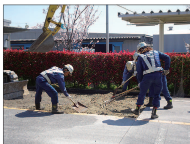
④碎石敷均し
