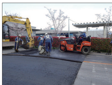
⑤レベル調整 アスファルト敷均し・転圧
