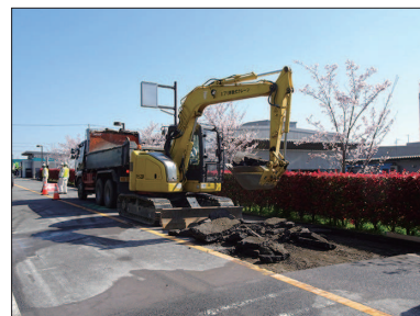
③既設アスファルト撤去
