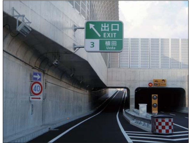
名古屋第二環状自動車道
