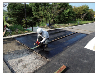
④型枠設置
