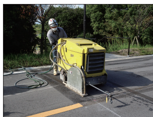
②カッター工(一部)
