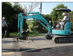
③既設アスファルト撤去
