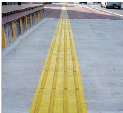
型枠工法（標準色）
