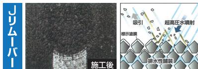
路面の凹凸形状を維持したまま標示塗膜を消去し、排水性舗装の排水機能を保持します。
