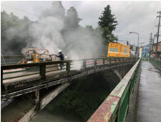
コンクリート舗装撤去工
