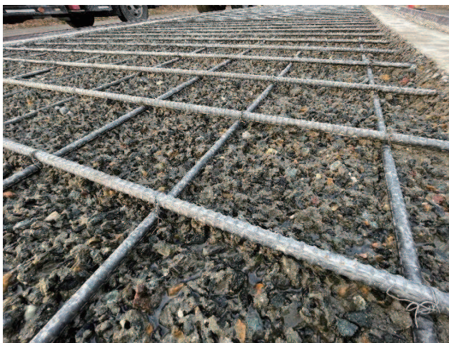
橋面の全面補修工
