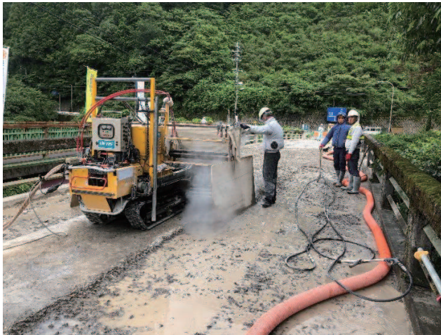
コンクリート舗装撤去工
