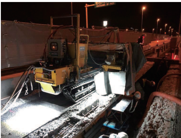
橋梁拡張工事にもなうPC鋼線定着具はつり出し
