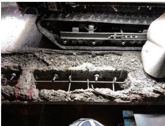
橋梁拡張工事にもなうPC鋼線定着具はつり出し
