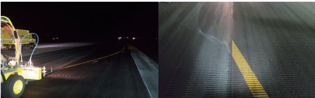
空港標識部施工状況
