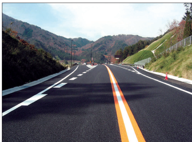
中部縦貫自動車道
